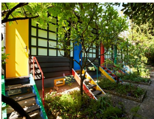
Unités de camping, façade nord, avec les escaliers menant aux logements © Benjamin Gavaudo - Centre des monuments nationaux
